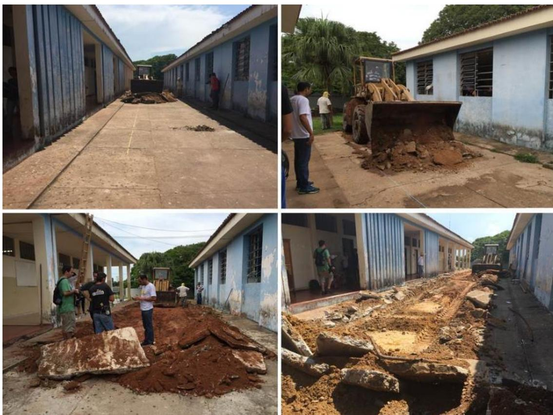
**Figura 2.** Remoção do concreto do pátio interno da escola.
